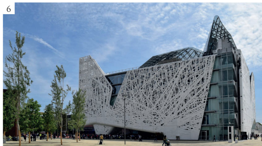
Figura 6 Nemesi & Partners, 'Palazzo Italia', Pabellón de Italia Expo Milan, 2015 . Milano, Italia. © Nemesi Architects. http://www.nemesistudio.it/it/progetti/tipologia/culture/item/1151-padiglione-italia-expo-milano-2015.html .
